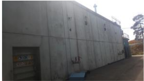
b) Dry Digester
