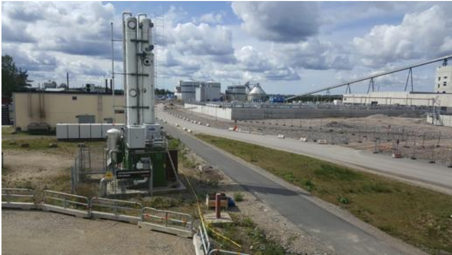
Gambar 16. Biogas Plant di Sobacken
